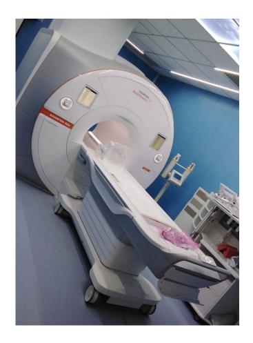
Sostituzione per obsolescenza di un Tomografo a risonanza magnetica in dotazione dal 2000 con un Tomografo RMN 1,5 Tesla Big Bore Simens.
